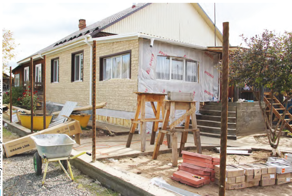
Машуковцы ремонтируют дома
